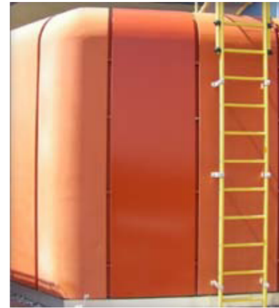
Bild 20: Metallfassade pulverbeschichtet, 15 Jahre nicht gereinigt mit Reinigungsmusterfläche
