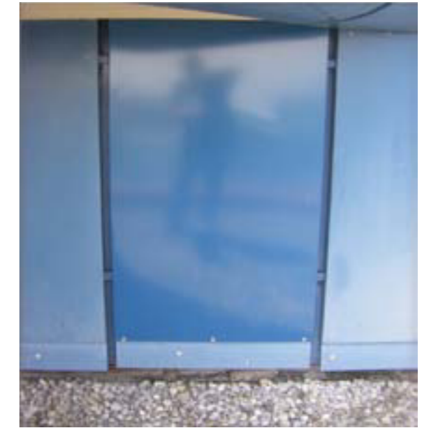
Bild 21: Detailaufnahme Metallfassade blau pulverbeschichtet mit Reinigungsmusterfläche
