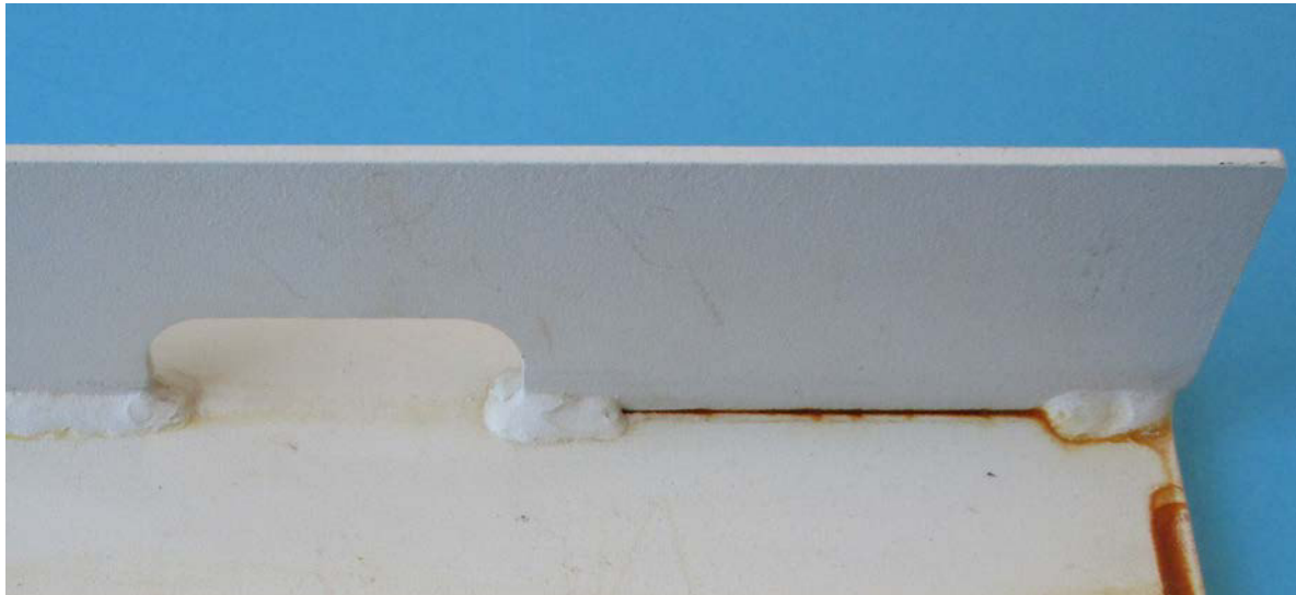
Abbildung 1: Spezialprüfkörper aus dem QIB-Projekt C5-2016 nach 1440 h neutralem Salzsprühnebeltest DIN EN ISO 9227, man beachte die Korrosionserscheinung an der nicht durchgezogenen Schweißnaht aufgrund von Spaltkorrosion.
