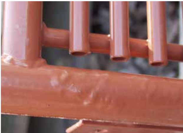
Abbildung 11: unverputzte Zinkverdükung
